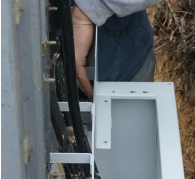
Abbildung 30: Ausrichten des KVz-Gestells auf Erdsockel
