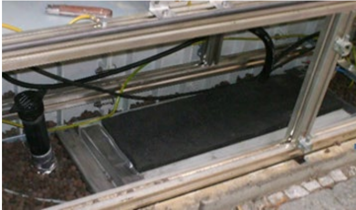
Abbildung 10: Abdichtung mit Schaumstoffmatte im Rahmen eines teilabgebrochenen KVz-Sockels
