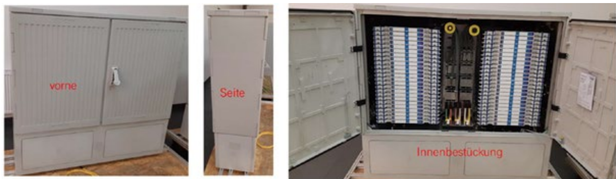
Abbildung 1: Beispielfoto eines FiberPOP-Standortes
