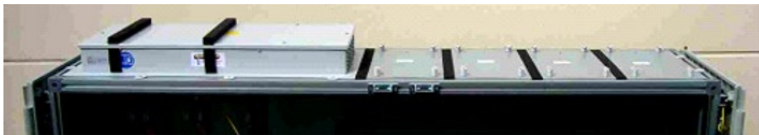
Abbildung 14: Nachrüstsatz für einen LL-WT fertig eingebaut
