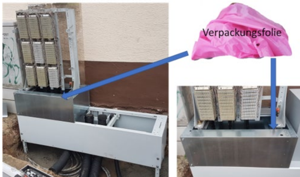
Abbildung 45: Abdichtung Sockel - Schritt 2
