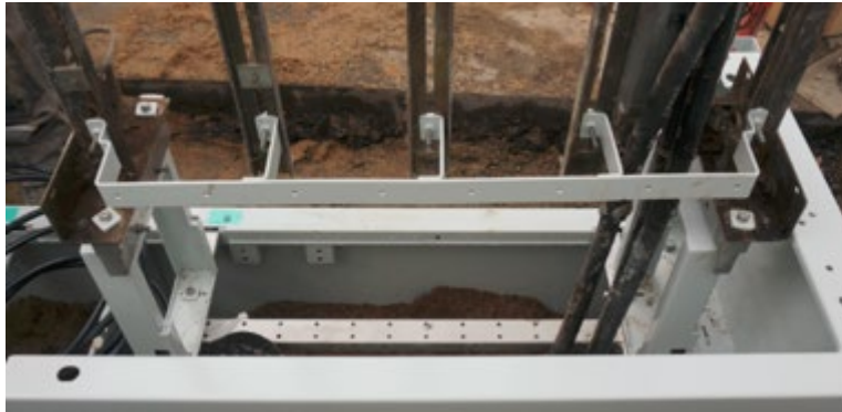
Abbildung 20: Versteifungsschiene (Lieferbestandteil des Huawei-Erdssockels)
