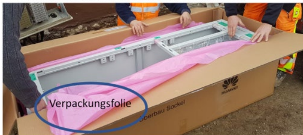
Abbildung 44: Abdichtung Sockel - Schritt 1
