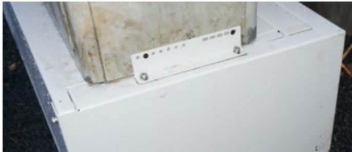
Abbildung 47: Haltewinkel für KVZ-Gehäuse
