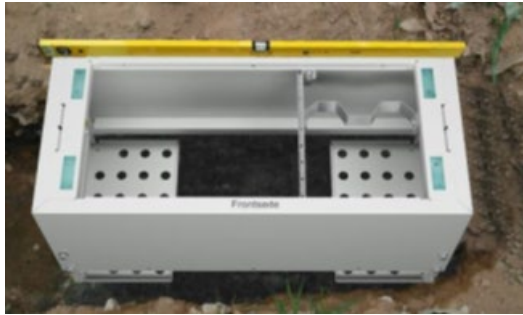
Abbildung 51: Huawei Erdssockel für Nebensteller (Anlieferzustand)
