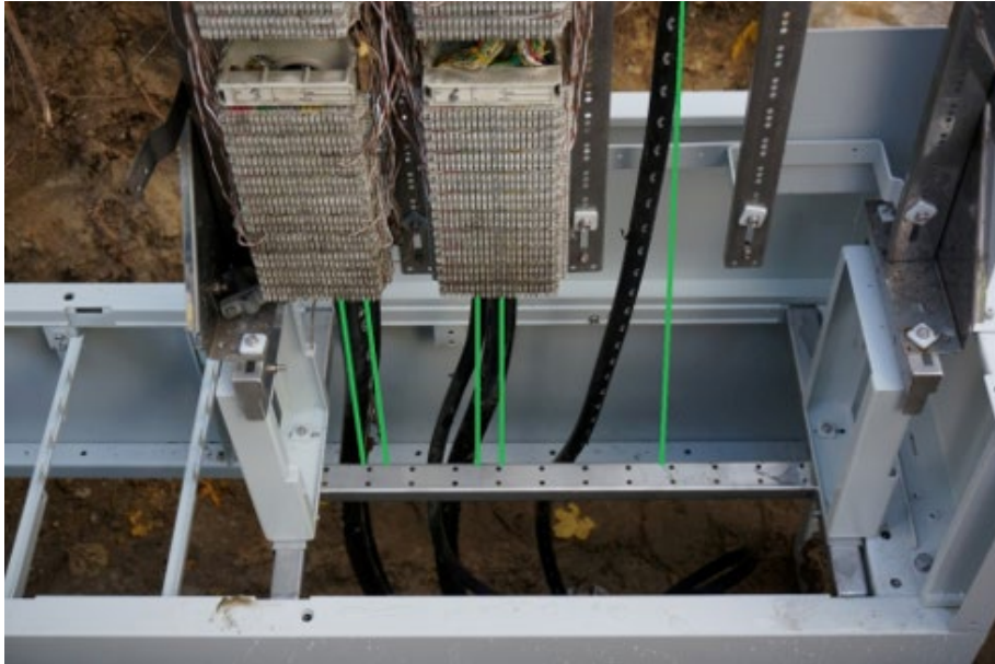
Abbildung 32: Exakte senkrechte Ausrichtung der hochzuführenden Kabel
