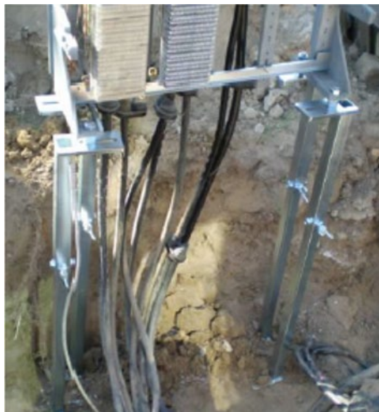
Abbildung 21: Umrüstgestell für KVz bei MFG-Überbau
