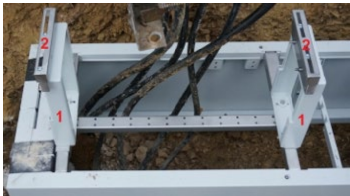
Abbildung 24: Sockel mit temporären Halterungen für KVz-Gestell
